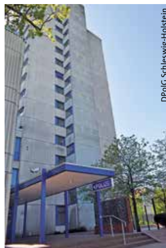
> Das Behördenhochhaus der PD Itzehoe
